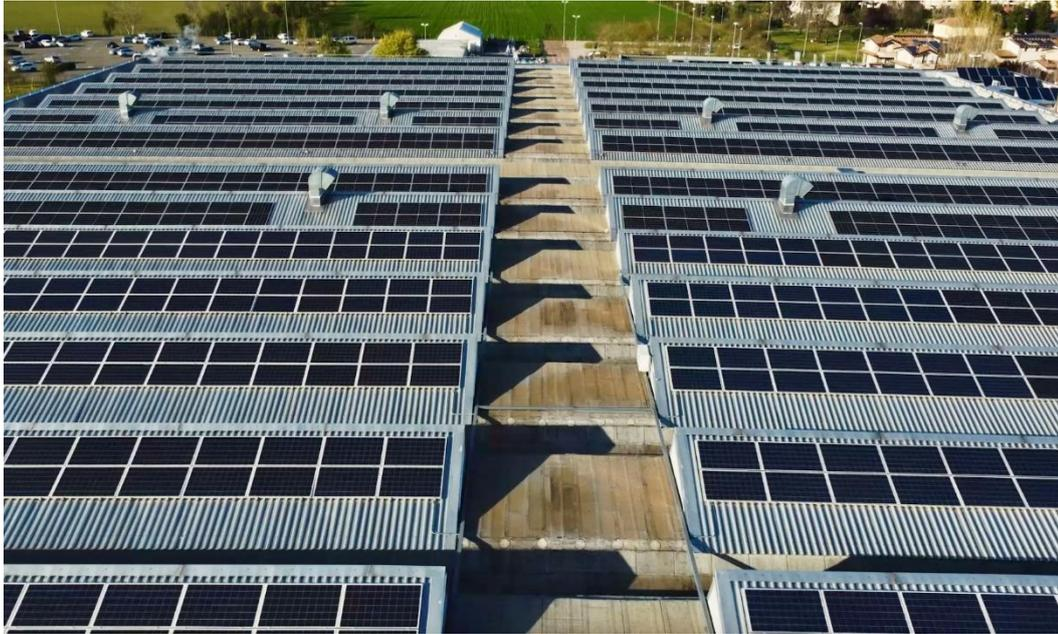
Sidel 在帕尔马工厂建造的大型光伏系统已全面投入运行，可满足该工厂 40% 的电力需求，并且每年减少 871 吨的二氧化碳排放量，相当于 43,500 棵树吸收的二氧化碳排放量。该系统是艾米利亚-罗马涅大区规模最大的企业光伏系统之一，配备 5,000 块太阳能电池板，能够生产 2,900 兆瓦时的电力，相当于 1,000 多个帕尔马家庭的年度用电量。
